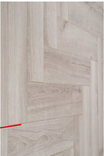
plafond: eikenhout delen in visgraatpatroon naden tussen de houten delen ijm akoestiek
